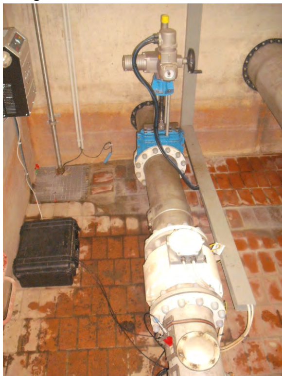
Abb. 1: IDM mit E-Schieber
